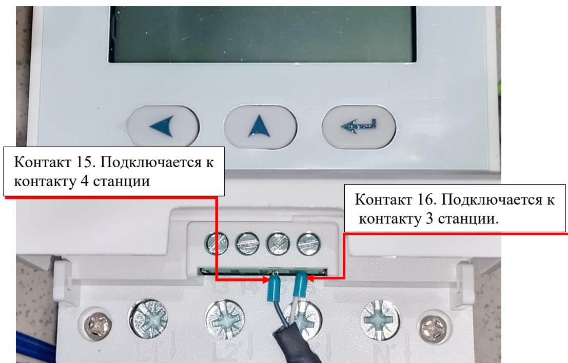
Рисунок 26. Подключение информационного кабеля к клеммам счетчика
